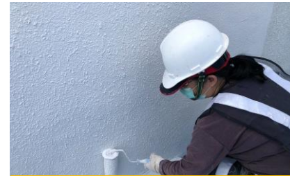
仿石面漆施作
