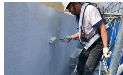
仿石面漆施作
