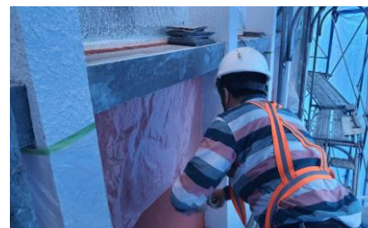
仿石漆施工防護
