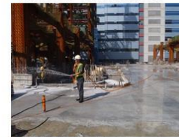
4.(3)防治措施 裸露地面灑水噴霧
