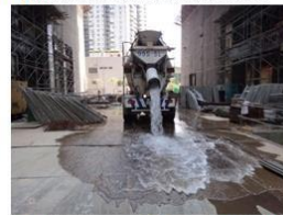
4.(1)防治措施 工地的車行路面灑水噴霧
