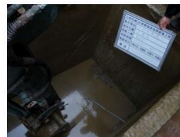
2.(1)防治措施 污泥沉澱措施
