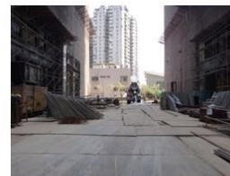
3.(1)防治措施 車行路面鋪設鋼板
