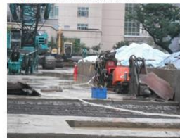
4.(2)防治措施 堆料棄土區灑水噴霧
