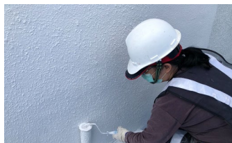
仿石面漆施作
