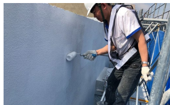
仿石面漆施作
